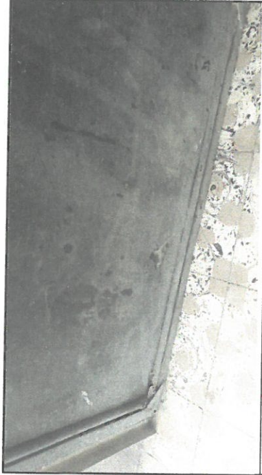
Reparacion y mantenimiento en puertas de aulas.
