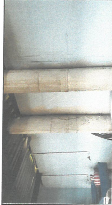
Cambio de chimeneas en cocina con tubos de concreto prefabricados en cocina.
